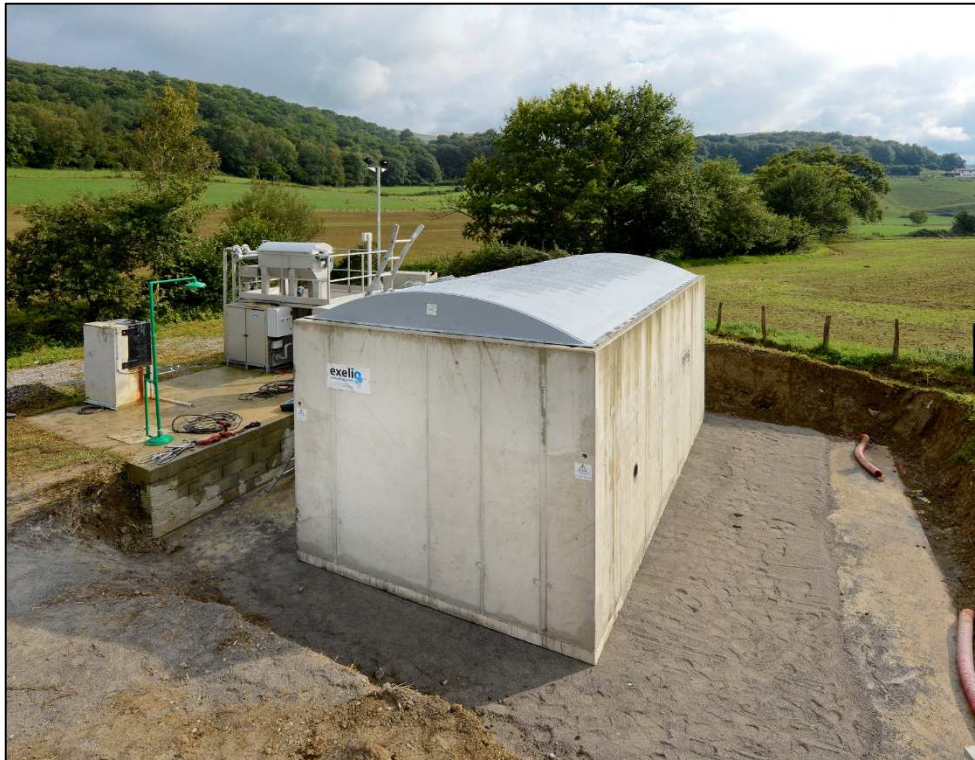
Cuve RBC mise en place sur site
