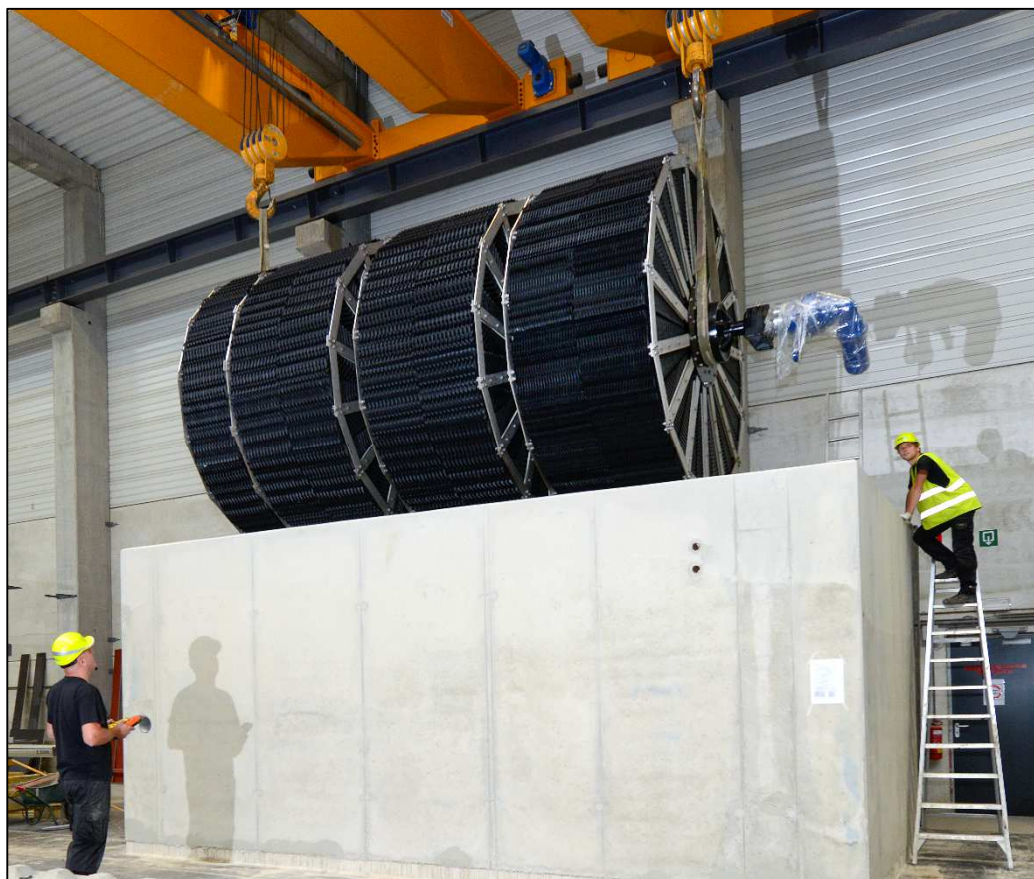
Placement du biorotor dans la cuve en béton
