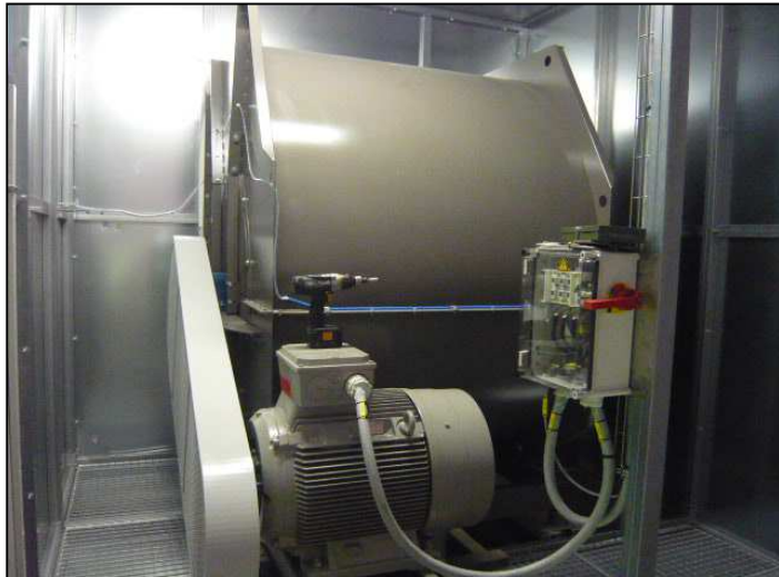
Ensemble moteur – ventilateur (Nicotra – Gebhaerdts type RZR 13-1120)
