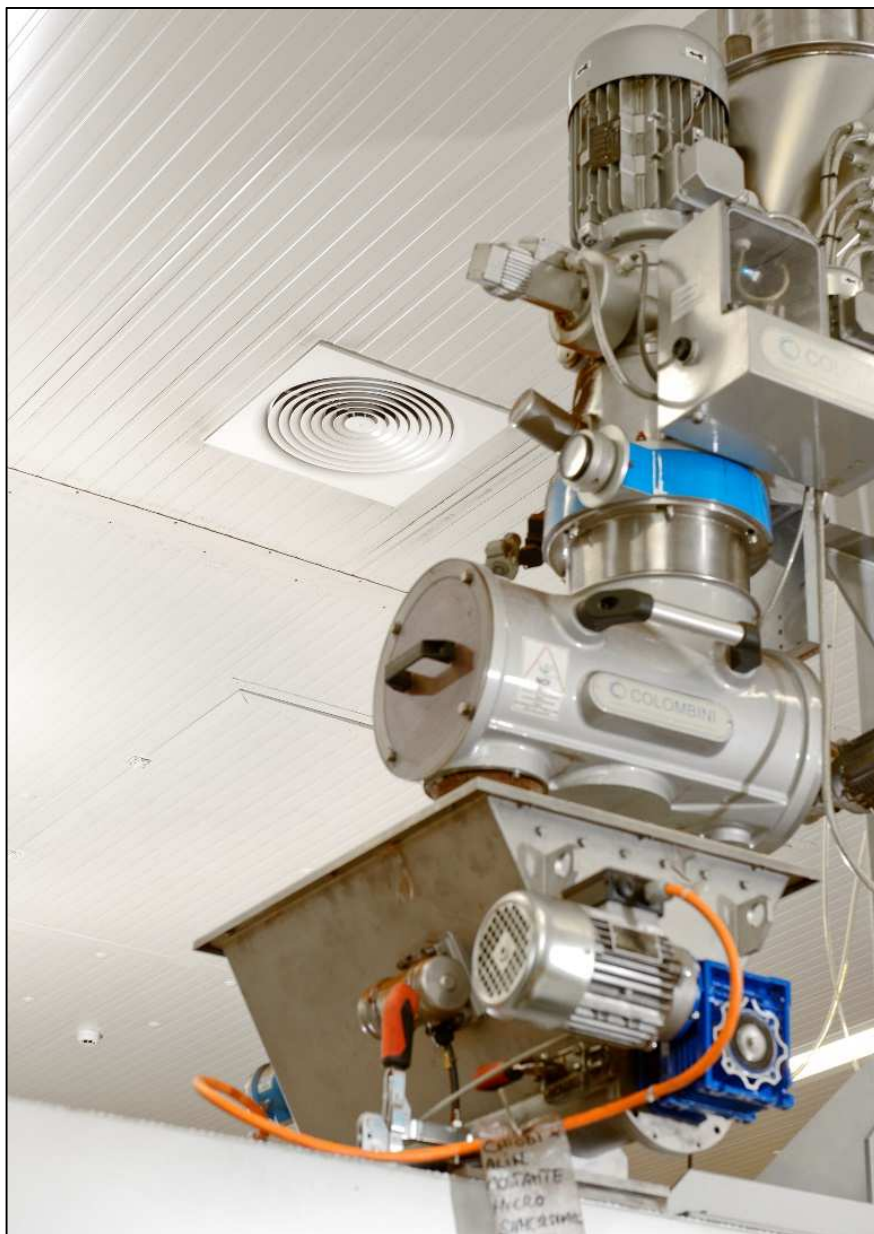
Bouche de pulsion
