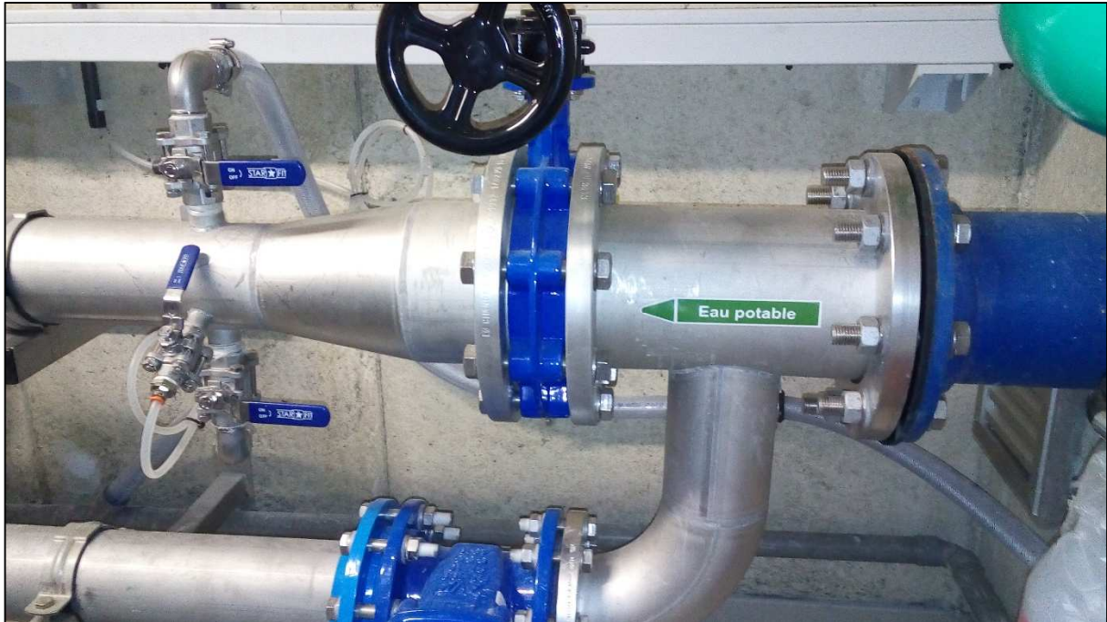
Ligne principale et ligne de by-pass
