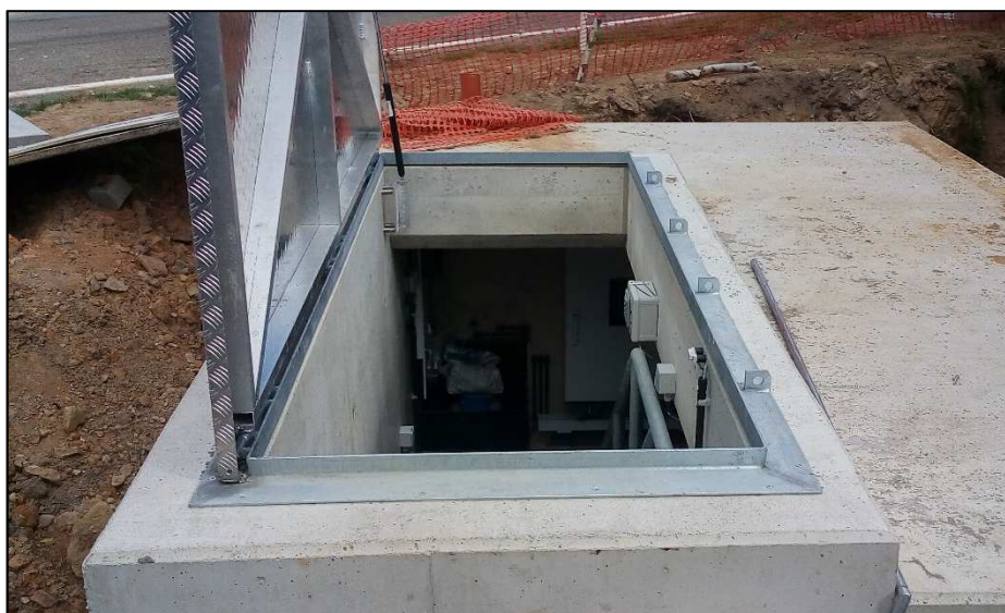
Accès à la chambre de chloration
