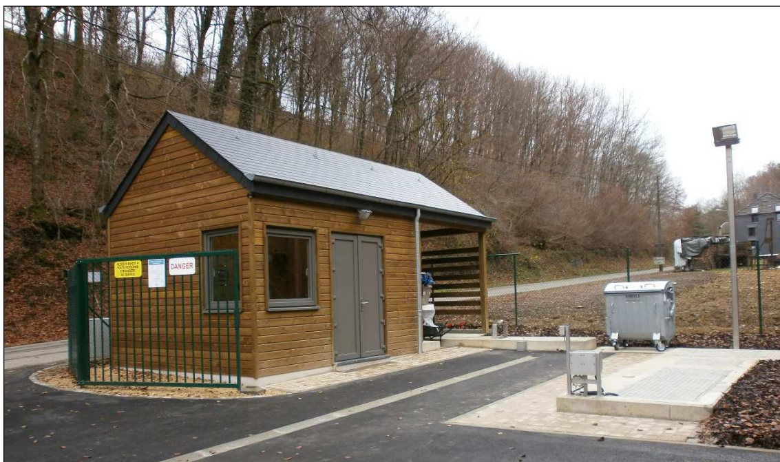
Relevage et local d'exploitation
