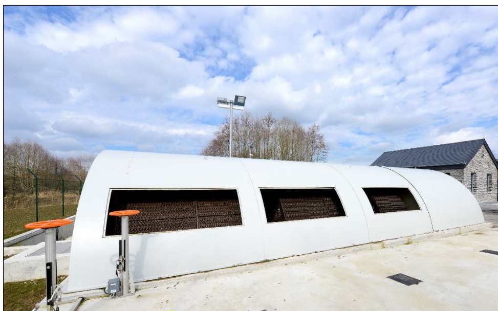
Couverture en polyester renforcé de fibres de verre du biorotor pamco®
