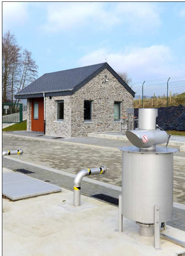
Bâtiment d'exploitation et unité de désodorisation du décanteur-digesteur
