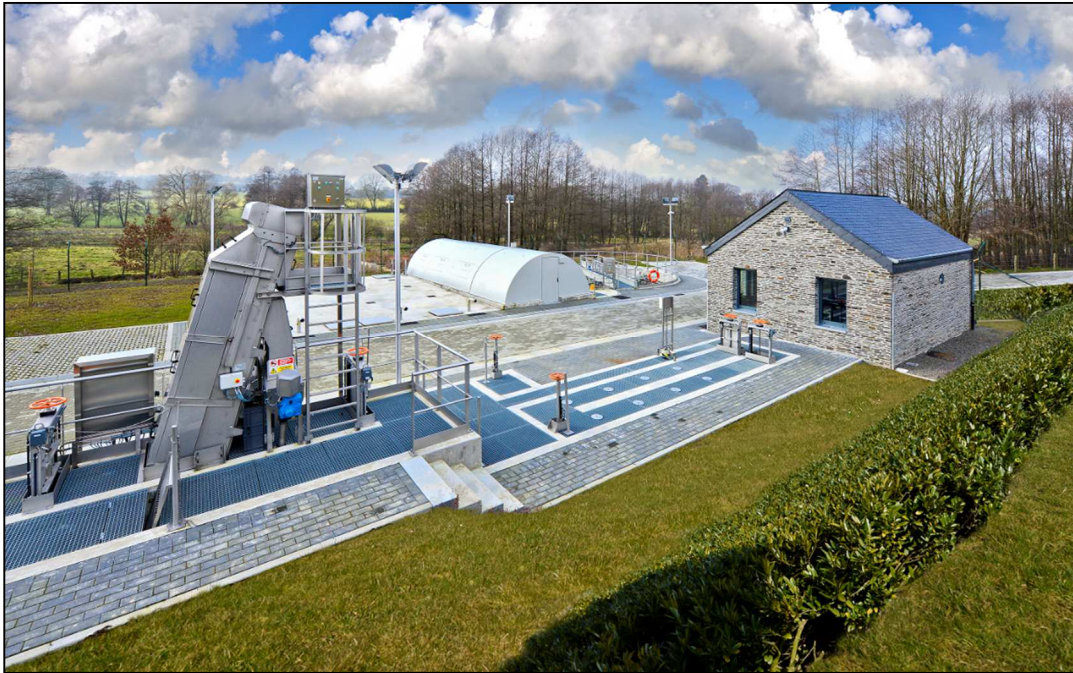
Vue générale de la station d'épuration
