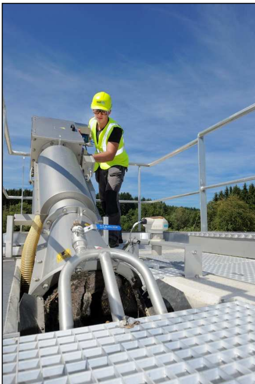
Tête du dégrilleur de type tamis-presse
