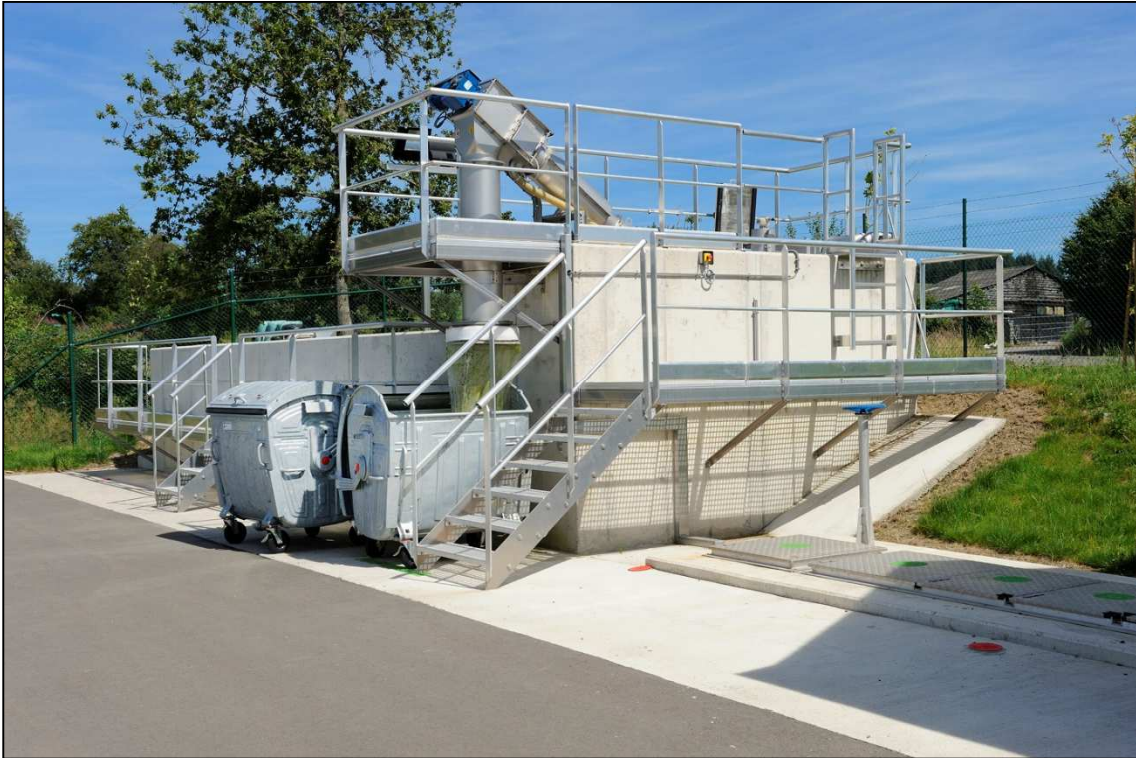
Vue générale du prétraitement (dégrilleur tamis-presse – désableur longitudinal)
