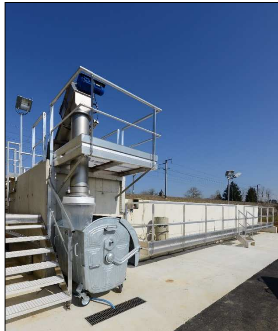
Prétraitement : dégrilleur fin type « tamis-press » et conteneur de stockage
