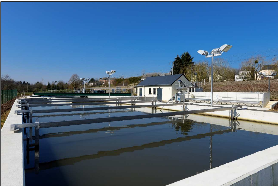
Vue générale de la station d'épuration depuis le bassin d'anoxie - aérobie
