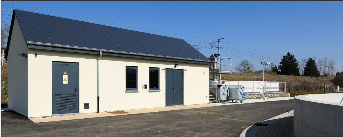
Bâtiment de service et local haute tension de la station d'épuration
