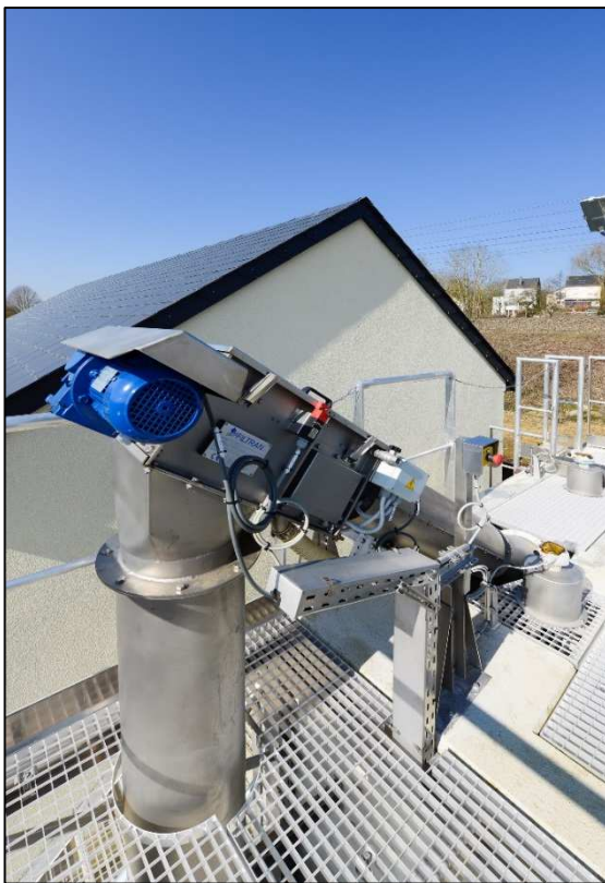
Prétraitement : dégrilleur fin type « tamis-press » et conteneur de stockage
