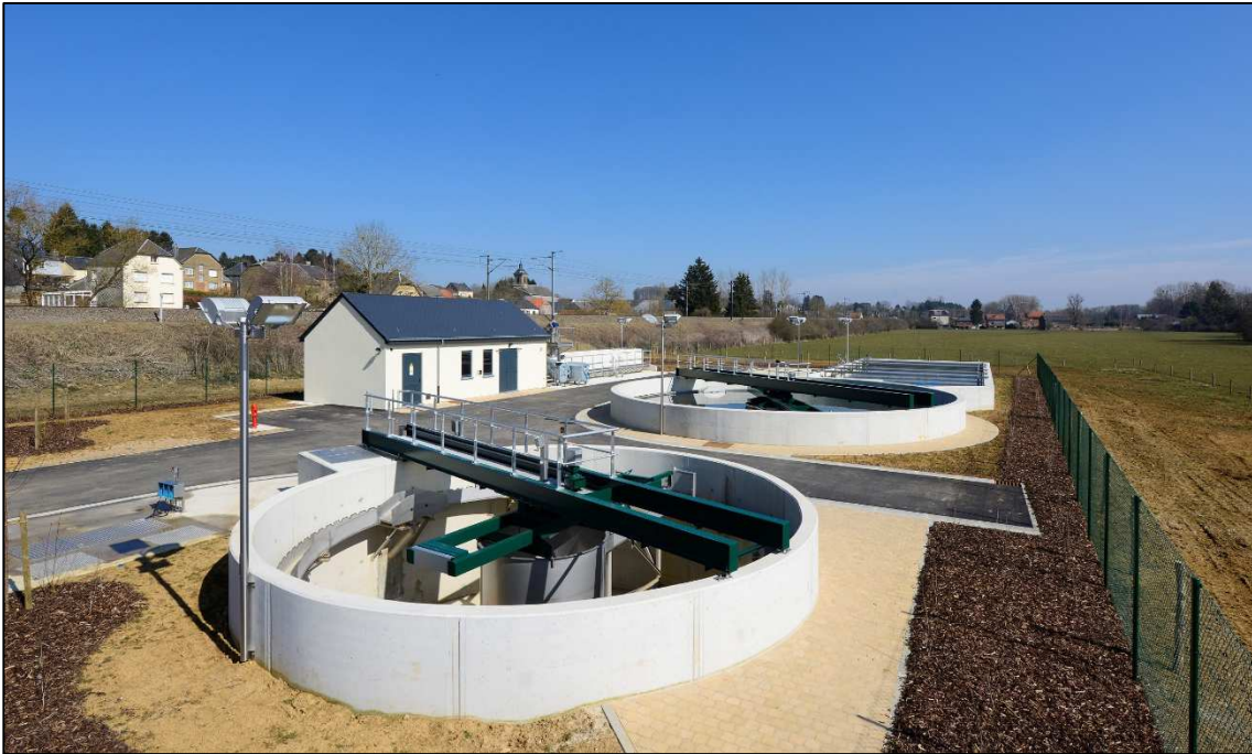
Vue générale de la station d'épuration depuis le bassin d'orage
