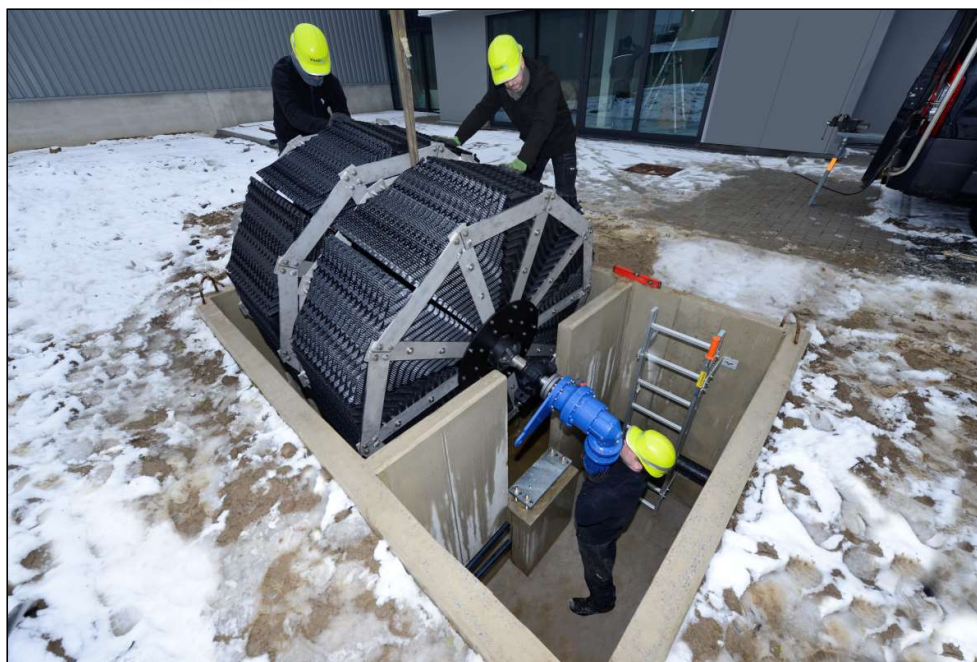
Placement du biorotor dans la cuve en béton
