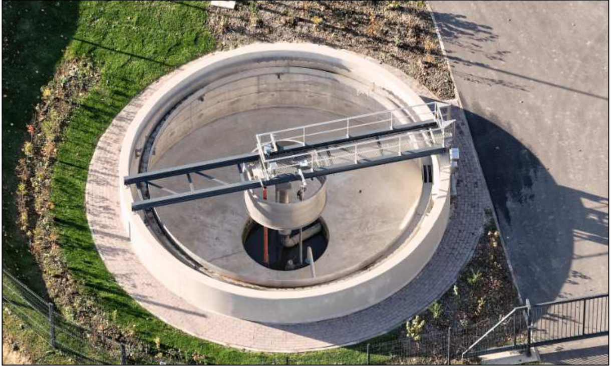
Vue aérienne du bassin d'orage
