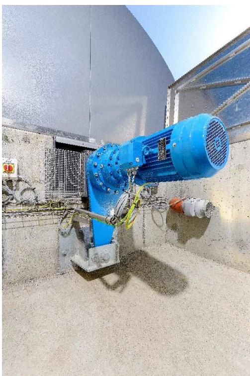
Motoréducteur du biorotor pamco®
