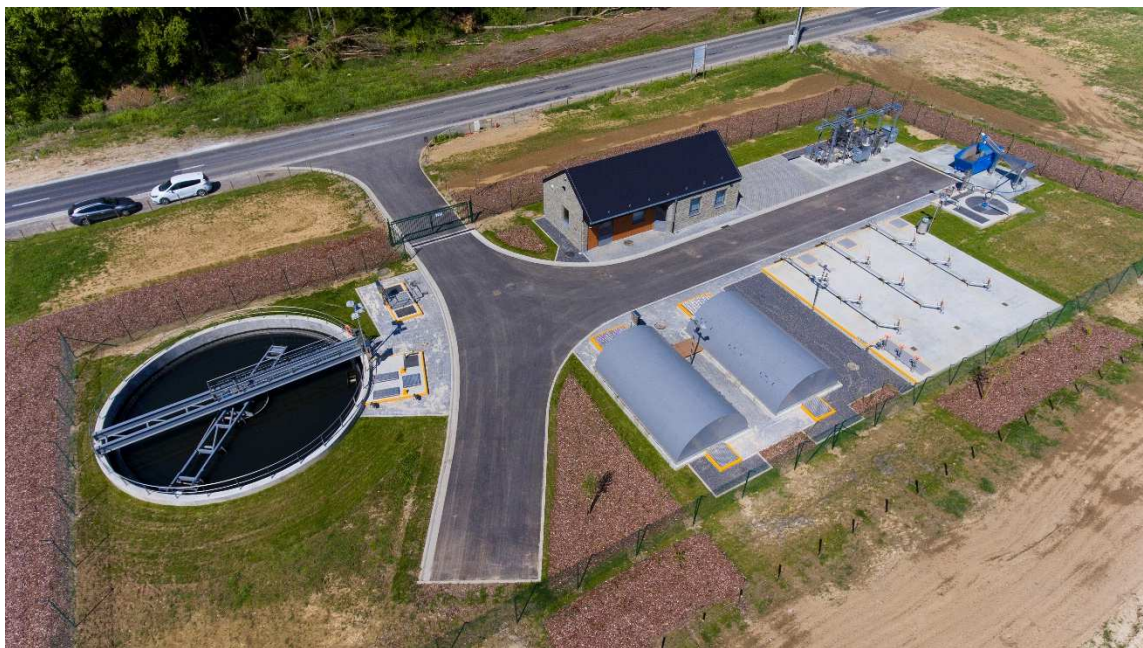
Vue d'ensemble de la station d'épuration
